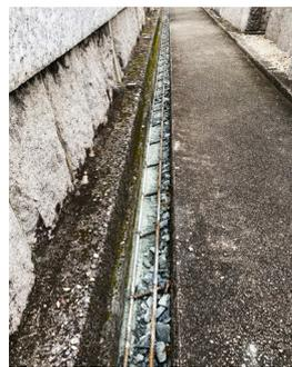
側溝に鉄筋が入りモルタルを入れる
